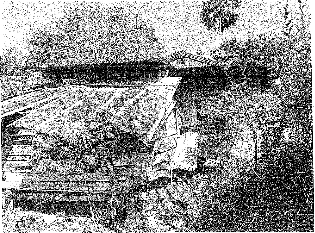
ภาพบ้านก่อนดำเนินการ
